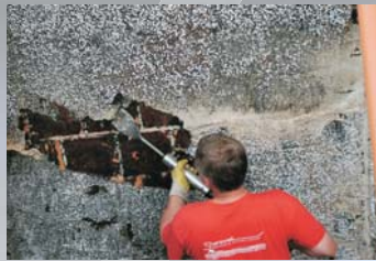
Abtragen von Bitumendickbeschichtung/Bitumen aller Art
