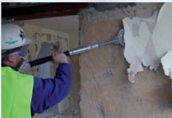
Entfernen von Innenputz - komplette Raumhöhe ohne Gerüst, ohne Bücken
