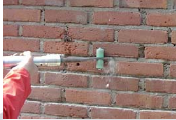
Räumen von Fugen in gleichbleibender Tiefe
