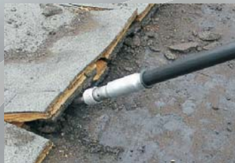
Räumen von Fugen in gleichbleibender Tiefe
