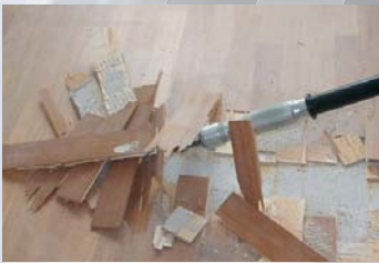
Lösen von Bodenbelägen aller Art
